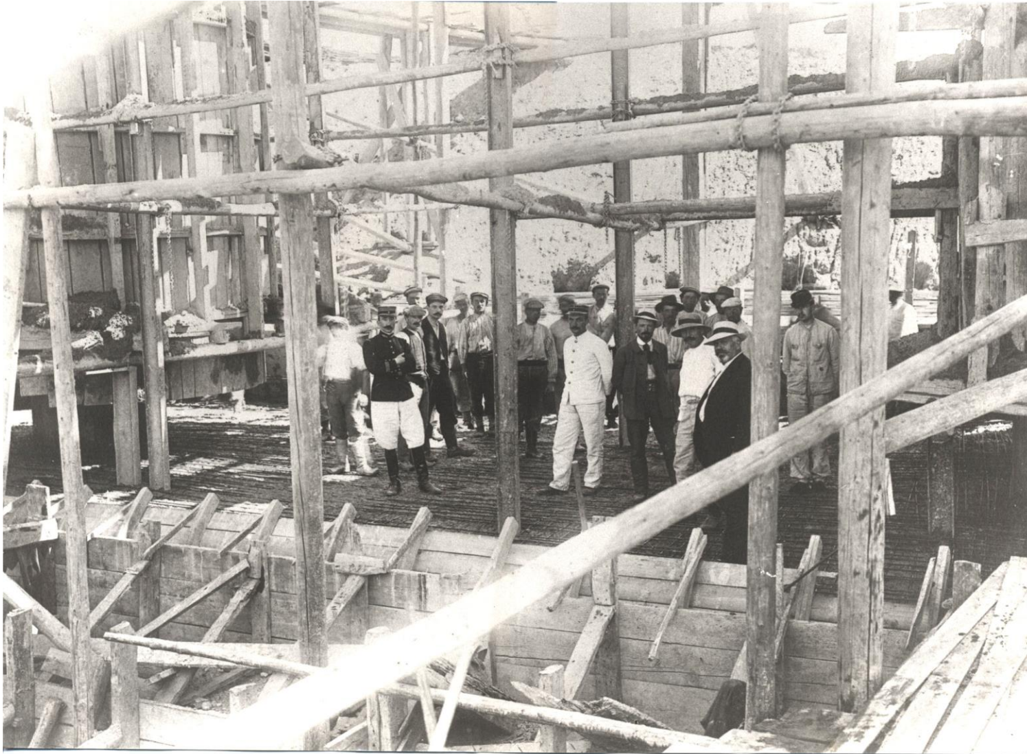
Modernisation du fort de Vézelois en 1888 / 1889 – Coffrages
